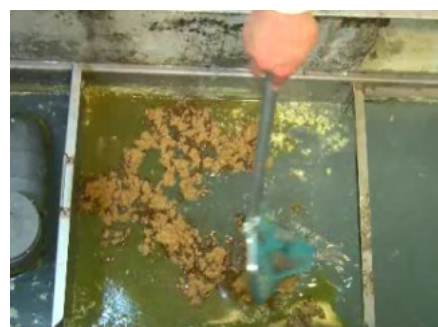
水面を撫でるように油とエコツーツーを 寄せ集めると即座に油を吸着します。 吸着後すくってポイで回収します。
